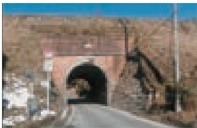
《大和街道架道橋》
