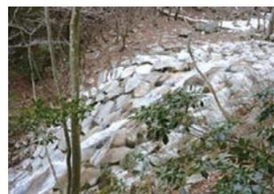
《なわだるみ堰堤 (傾斜面)》
