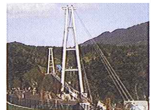
九重“夢”大吊橋
